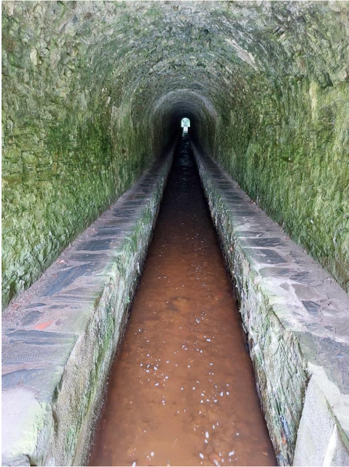
La Rigole de la Montagne dans la Percée des Cammazes ou Voûte Vauban
